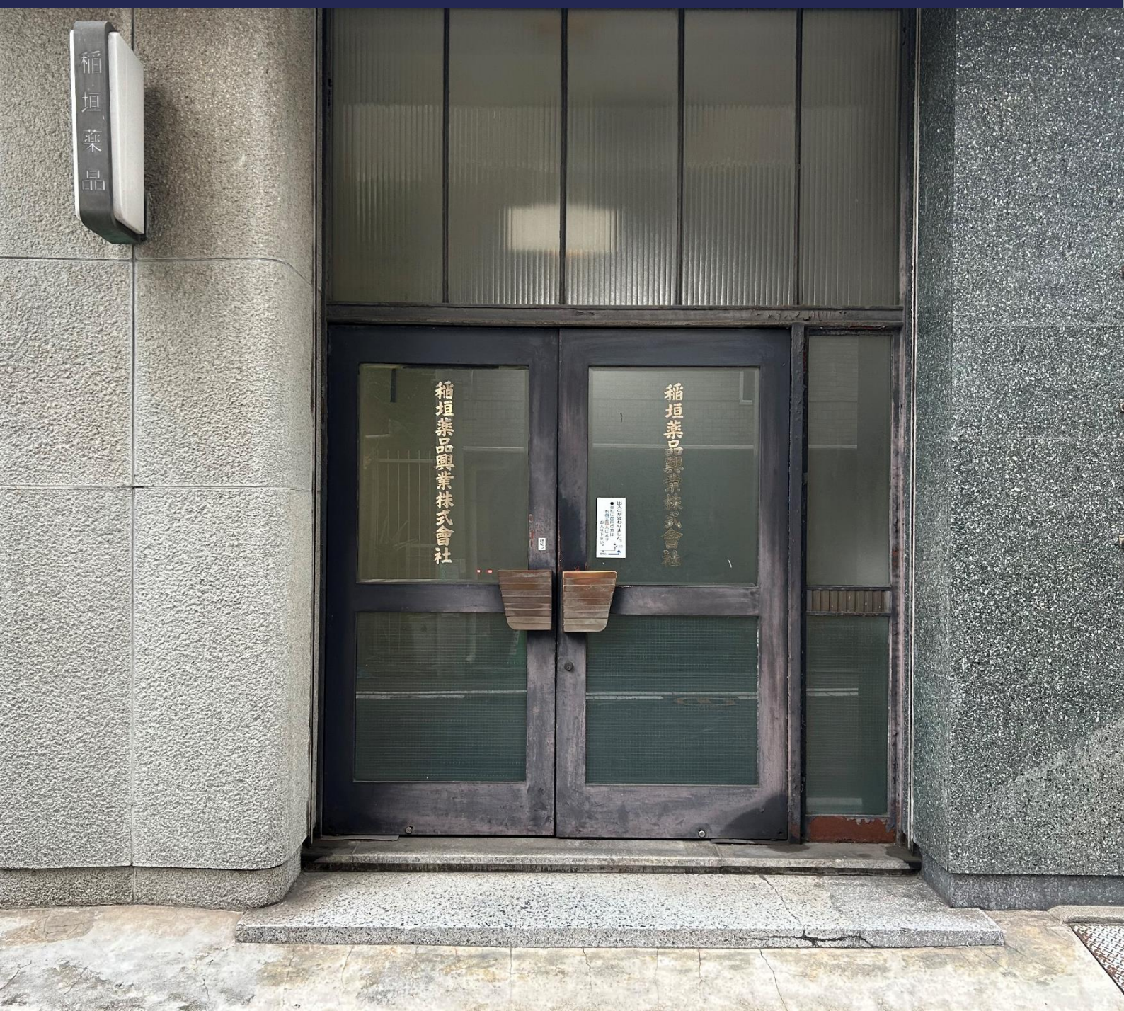
本社旧エントランス
